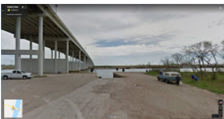
hwy 36 bridge.JPG 156K
