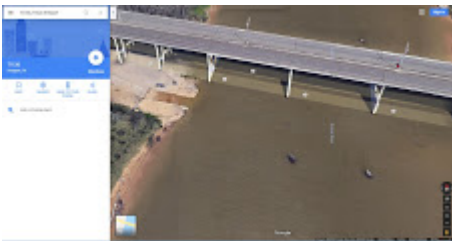
hwy 36 bridge_2.JPG 136K
