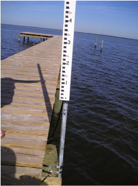
872-9905 Orifice 2 leveling NW.jpg
